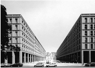
Leibnizkolonnaden am Walter-Benjamin-Platz, Hans Kollhoff Architects
